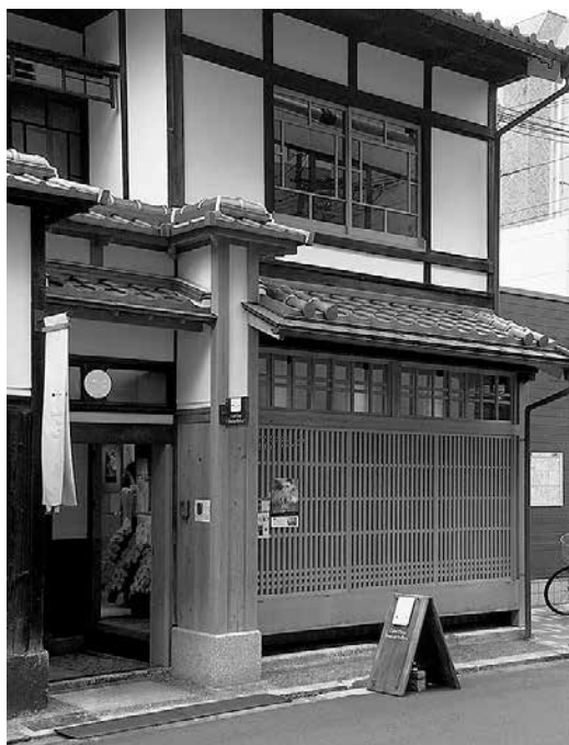
第12図 古民家改修・新旧材混合
